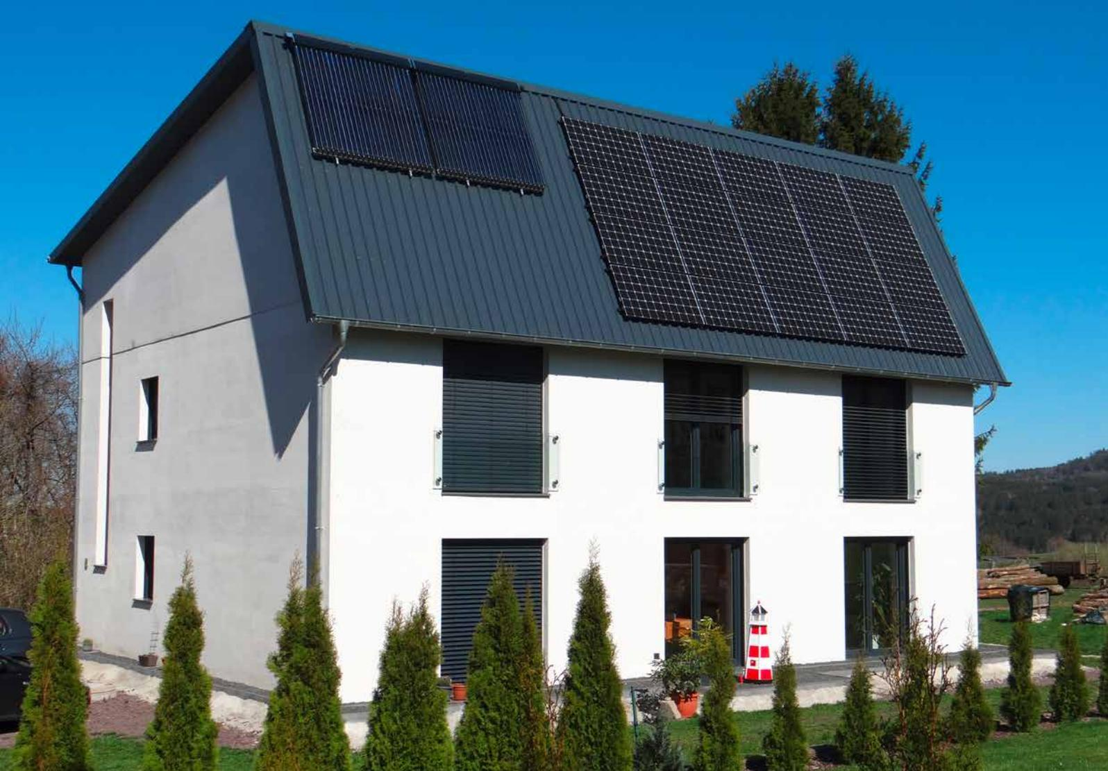
Photovoltaik- und Solarthermie-Module können durchaus gemeinsam auf dem Dach angebracht werden (oder die bereits erwähnten kombinierten „PVT-Module“). So kann die Energie der Sonne sowohl zur Stromerzeugung als auch zur Wärmebereitung genutzt werden.
